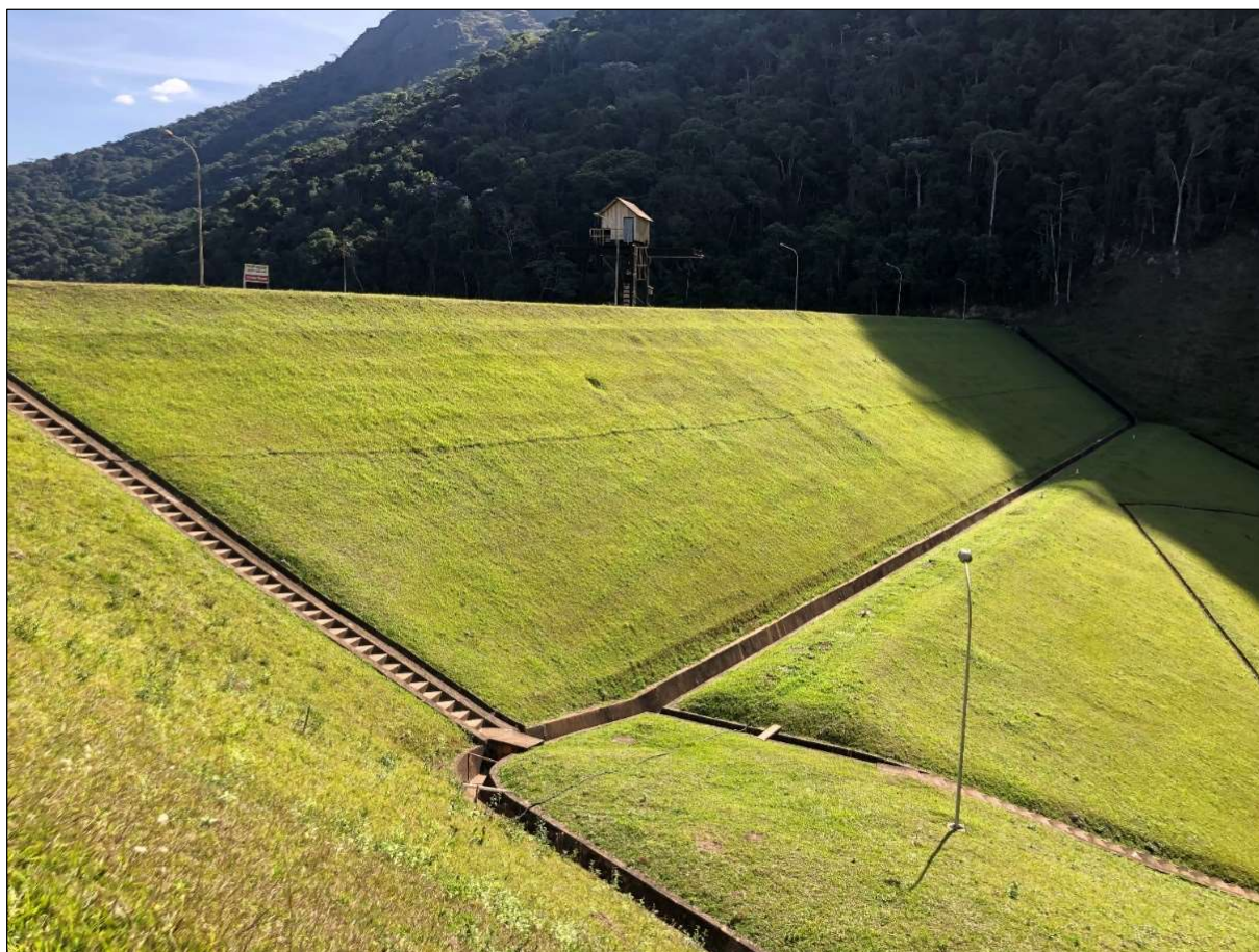
Figura 5.1 – Talude de jusante da Barragem Ribeirão da Cachoeira.
