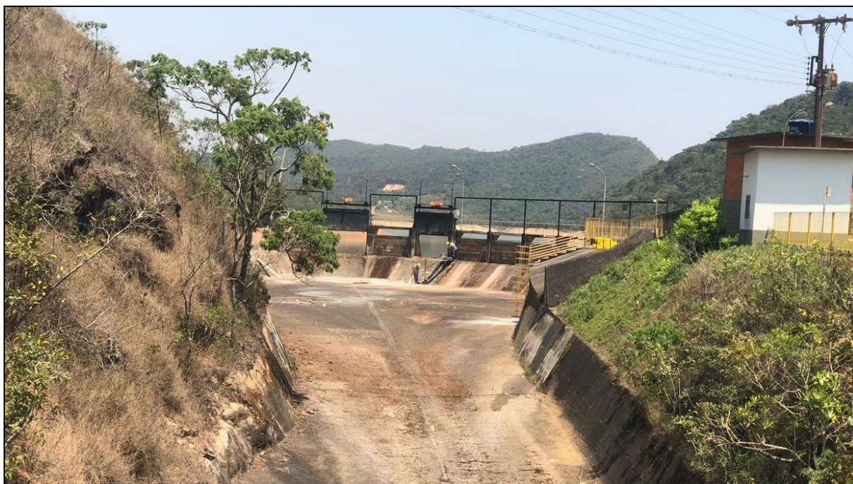
Figura 5.2 – Estrutura vertente da Barragem Ribeirão da Cachoeira.
